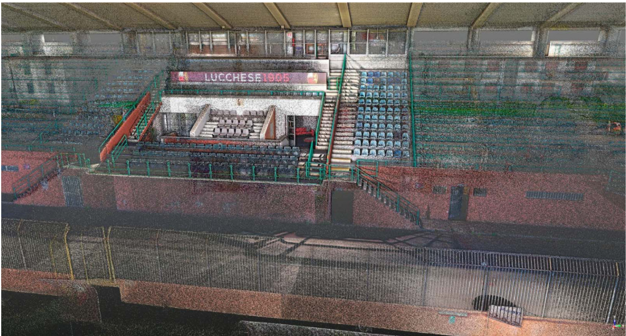
Rilievo fotogrammetrico da SAPR (Drone)
